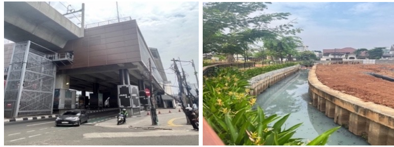
Gambar 2. Akses MRT ke UFC (kanan); Area Pembangunan Lanjutan (kiri)
