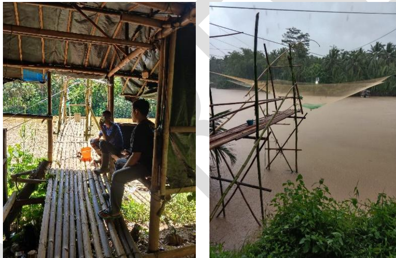
Gambar 3. Konstruksi saung sirib
